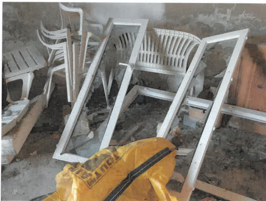
Dépôts d'ordures et de gravats
