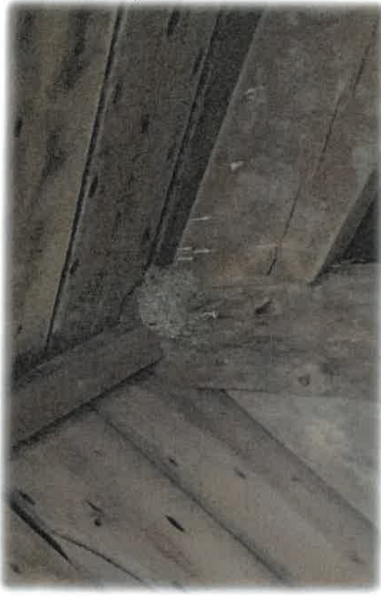
A l'étage, les nids sont construits sur la charpente.
